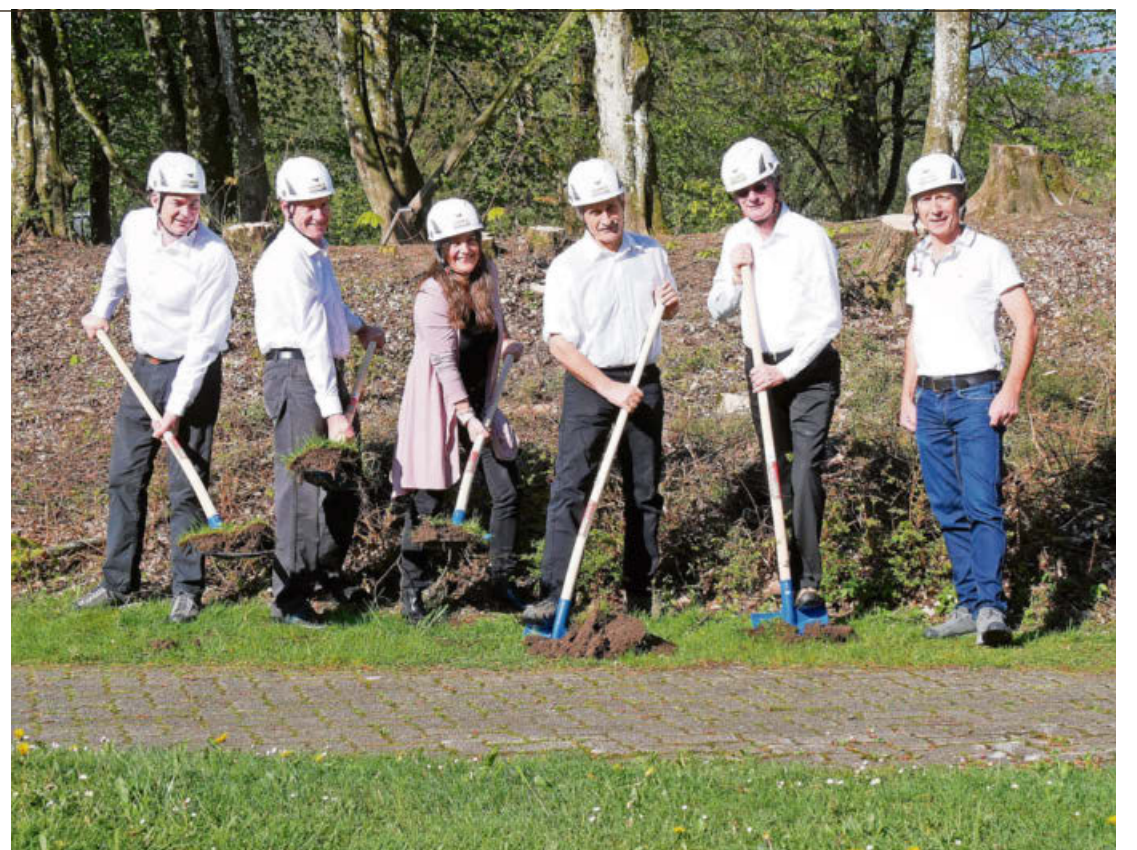
Feiern den Baustart (von links): Gemeindepräsident Andreas Sudler, VR-Präsident Rudolf Rüegg, Margot Menzi, Max Bosshard, Rudolf Bertels vom Wärmeverbund und Architekt Lukas Keller. Foto: Noah Salvetti
