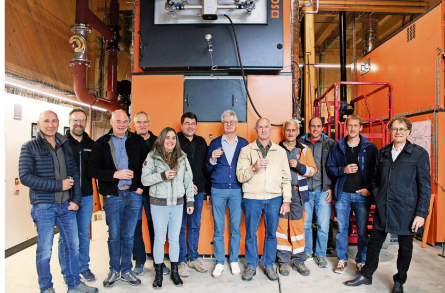
Zeit zum Anstossen: Der Wärmeverbund Bauma nimmt seine Heizzentrale in Betrieb. Mit dabei Gemeindepräsident Andreas Sudler (Dritter von links) und Verwaltungsratspräsident Rudolf Rüegg (Fünfter von rechts).
