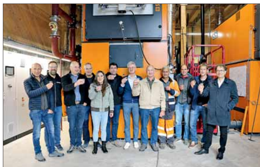
Beteiligte vor einem von zwei Schmid-Kesseln: Behörden, Forstdienst, Planer und Betreiber stoßen auf den Wärmeverbund Bauma an.
